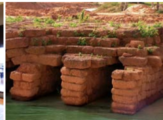
アンコール時代の橋
